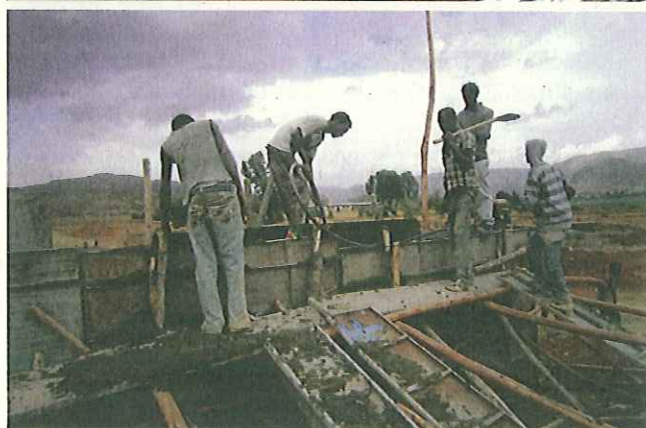
Treballs de fonament i pujada de la presa de Wukro
