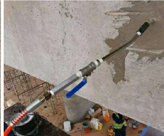
Injecció de fissures amb resina epoxi Epojet
