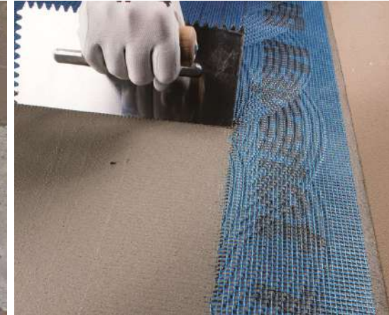
Armat de membrana impermeable amb malla Mapenet 150
