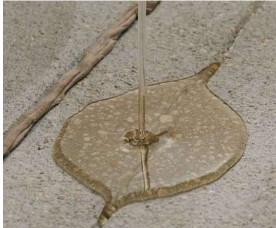
Farciment de fissures per abocament amb resina epoxi Epojet
