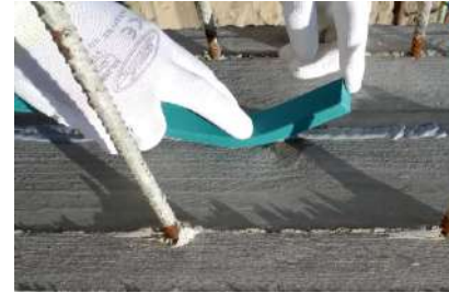
Perfils hidroexpansius Idrostop Formats: ▪ 20x10mm ▪ 20x15mm ▪ 20x25mm Augment de volum retardat.
