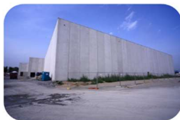
Refuerzo de estructuras de hormigón
