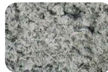
Refuerzo con morteros de altísima resistencia HPC
