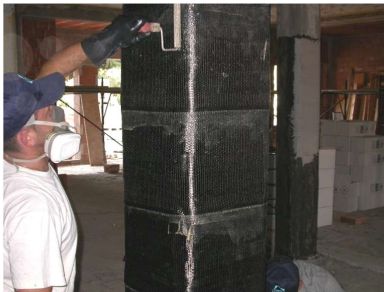
10.- Impregnació del teixit amb segona capa de Mapewrap 31 .
