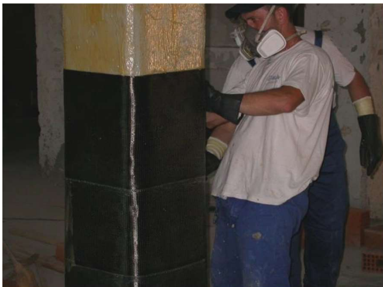
9.- Col·locació del teixit exercint pressió amb un corró acanalat.
