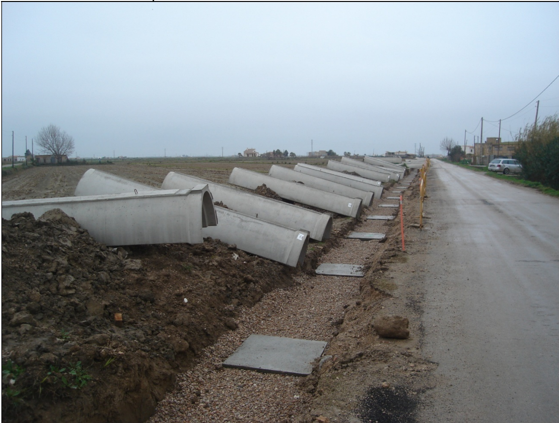
Foto 6: Dipòsit de les canaletes al costat de l'obra i el camí.
