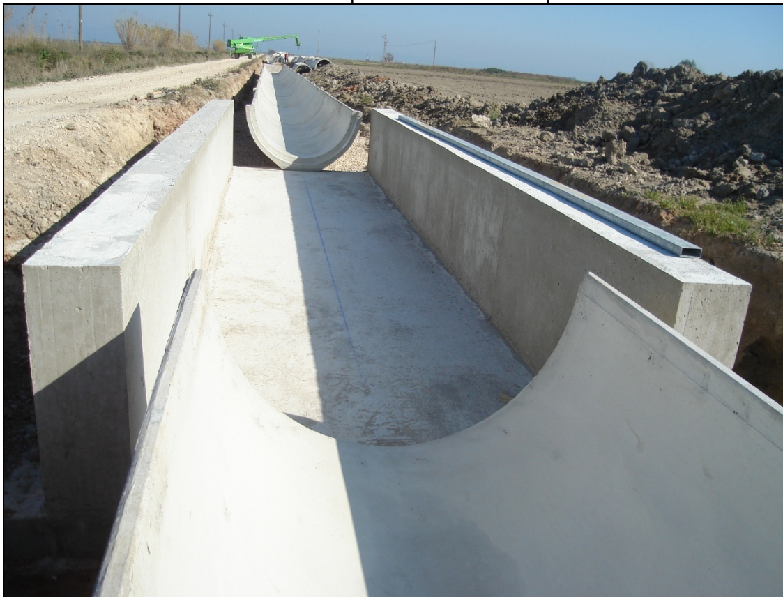
Foto 8: Detall de l'alineació recta de la canaleta prefabricada de formigó armat.
