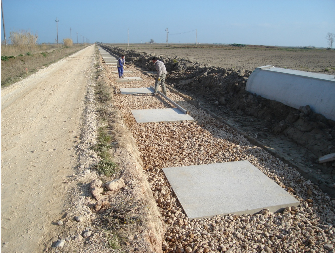
Foto 5: Anivellant les graves existents entre les sabates de formigó armat.
