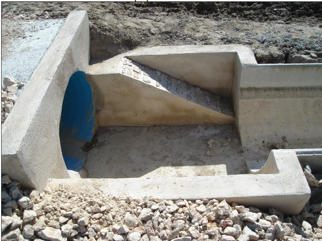
Foto 10: Detall de rampa per a ànecs i d'altres aus anàtids.
