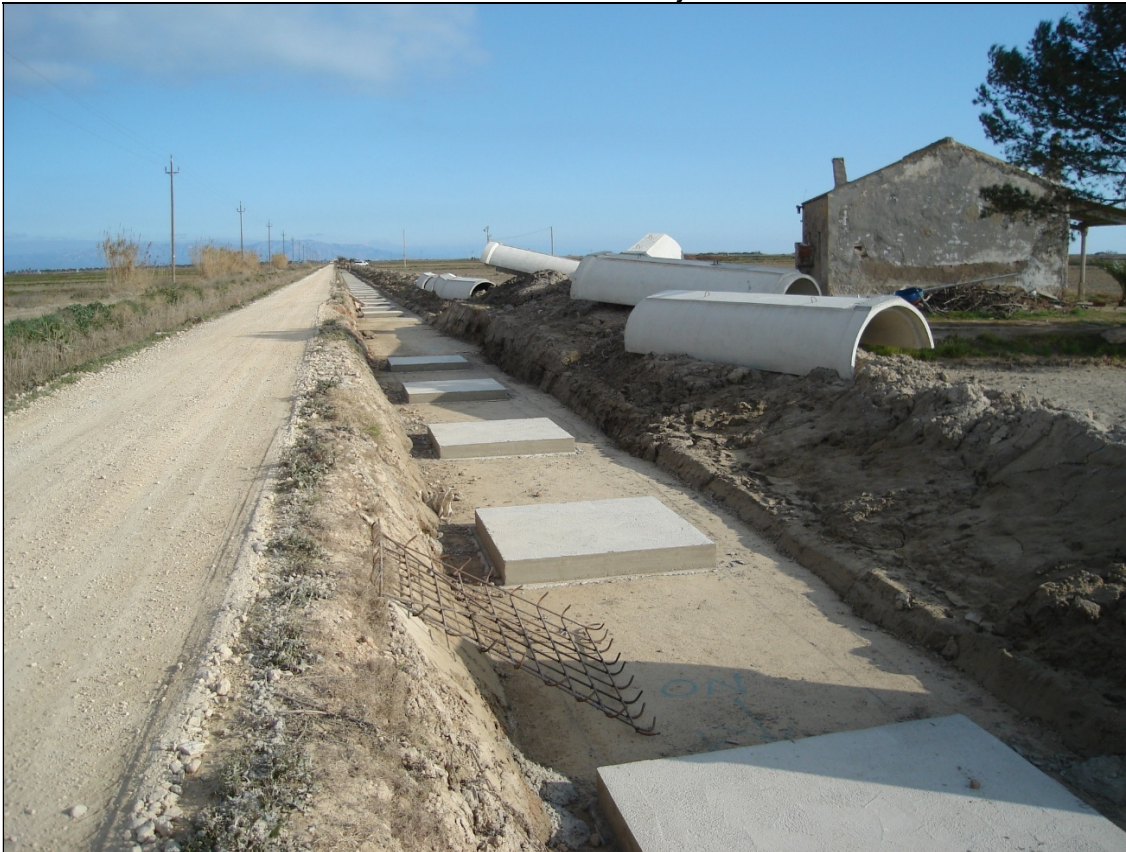
Foto 4: Sabates de cimentació ja enllestides.
