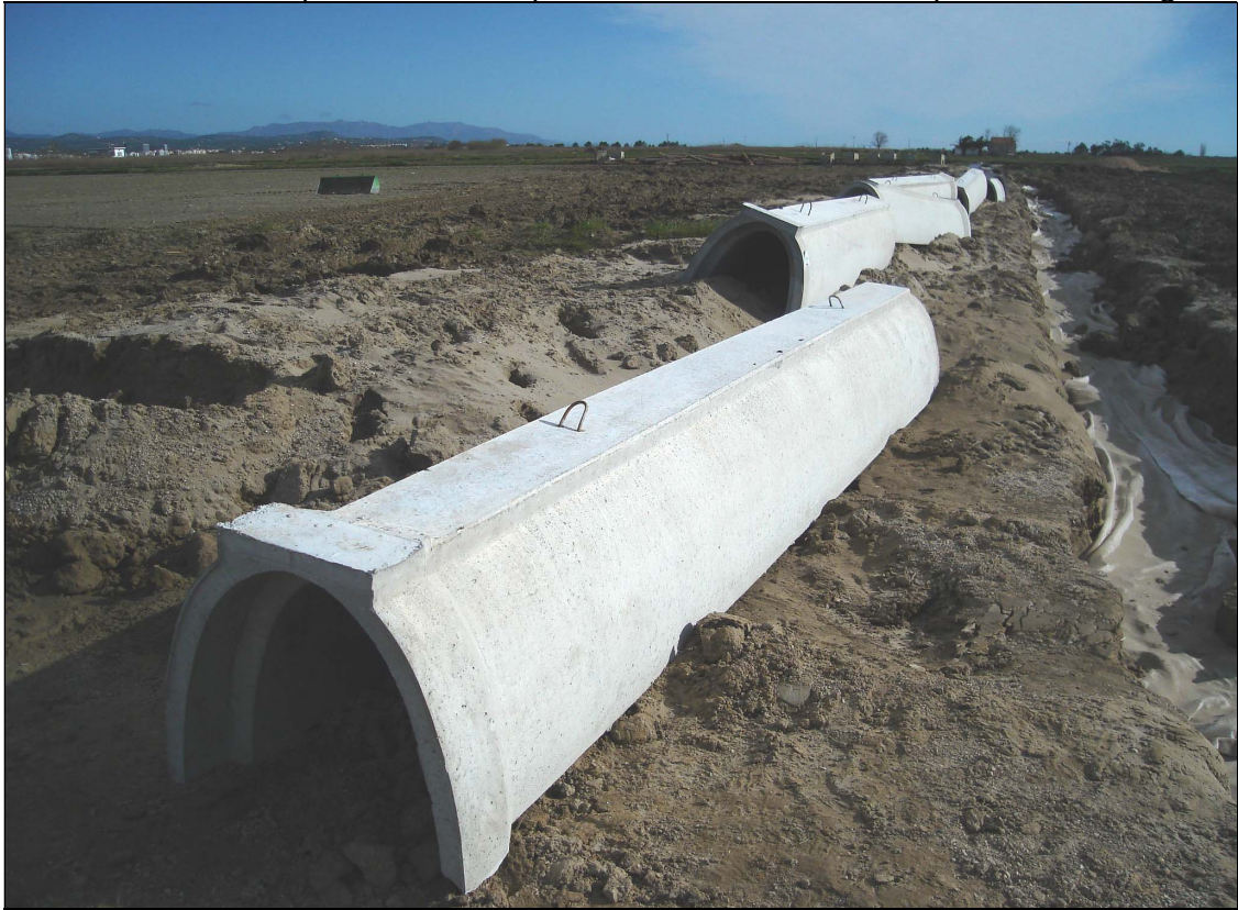
Foto 1: Canaletes prefabricades dipositades al lateral de la sèquia terrissa antiga.
