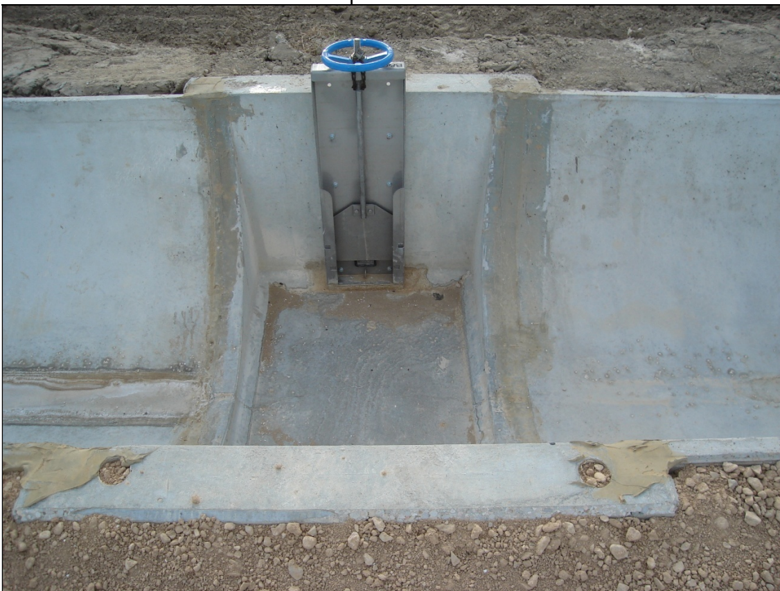
Foto 14: Comporta metàl·lica de reg en l'arqueta de derivació a parcel·la.
