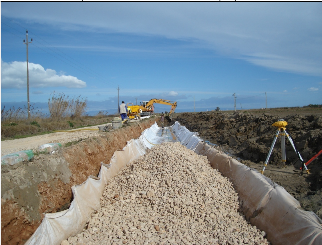
Foto 2: Preparació i anivellat del seient de la sèquia prefabricada.
