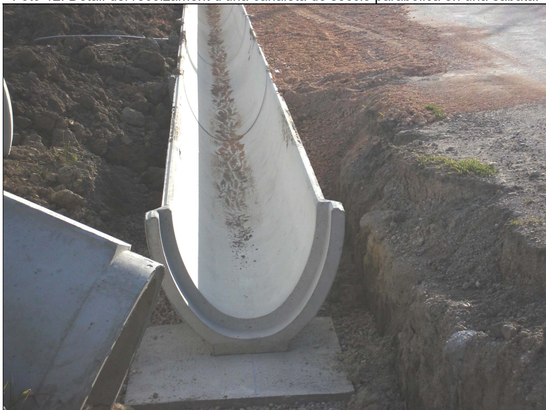
Foto 12: Detall del recolzament d'una canaleta de secció parabòlica en una sabata.
