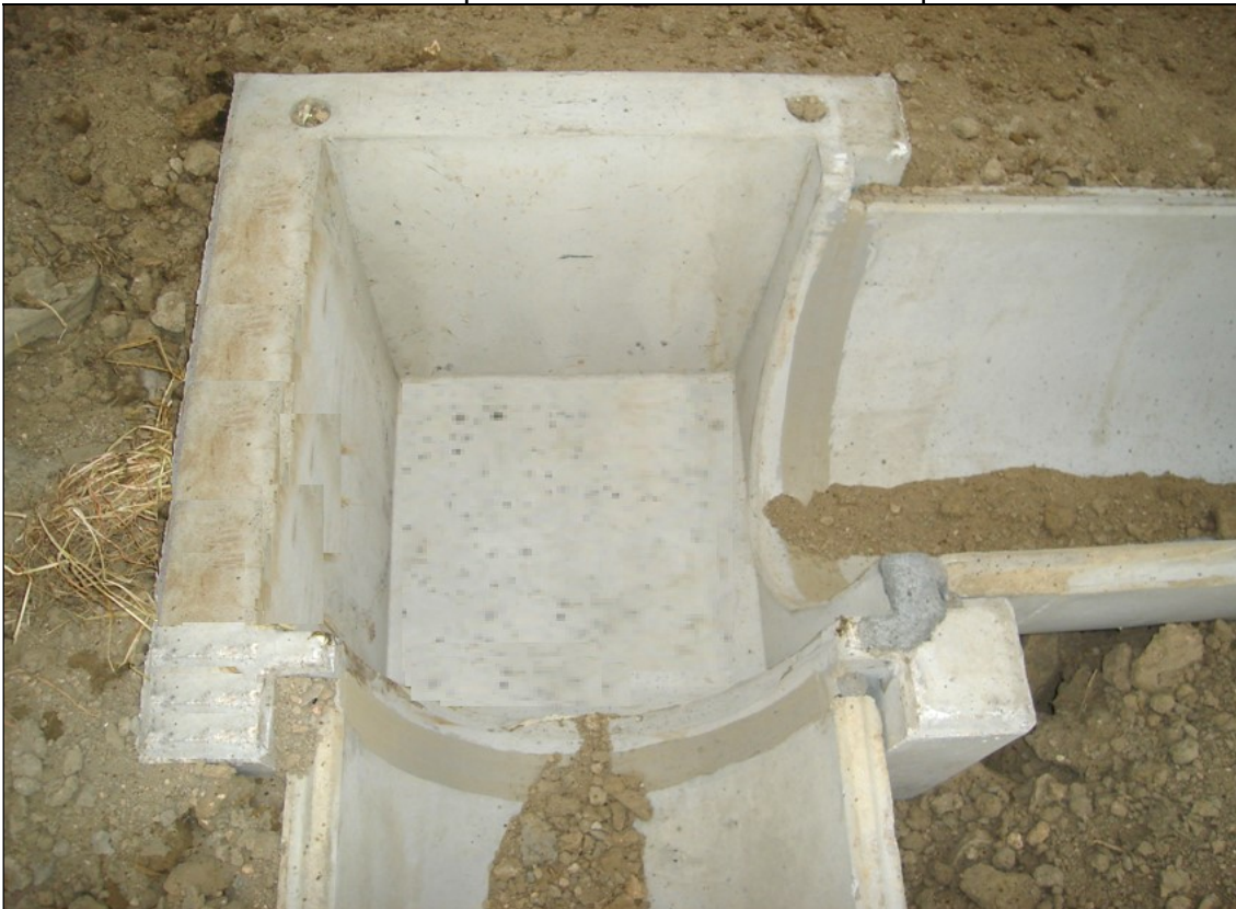
Foto 16: Detall d'arqueta d'unió de dos trams de sèquia a 90°.
