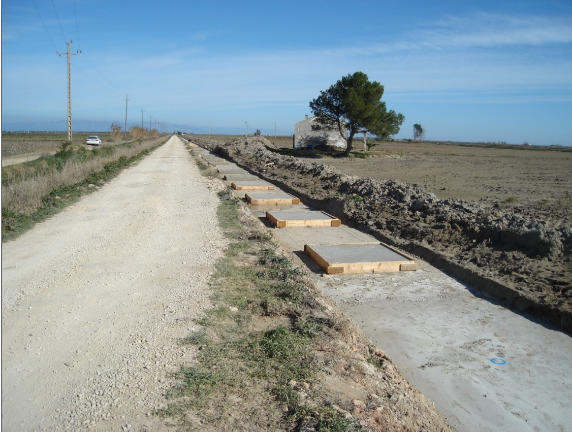
Foto 3: Sabates del seient ja encofrades i plenes.
