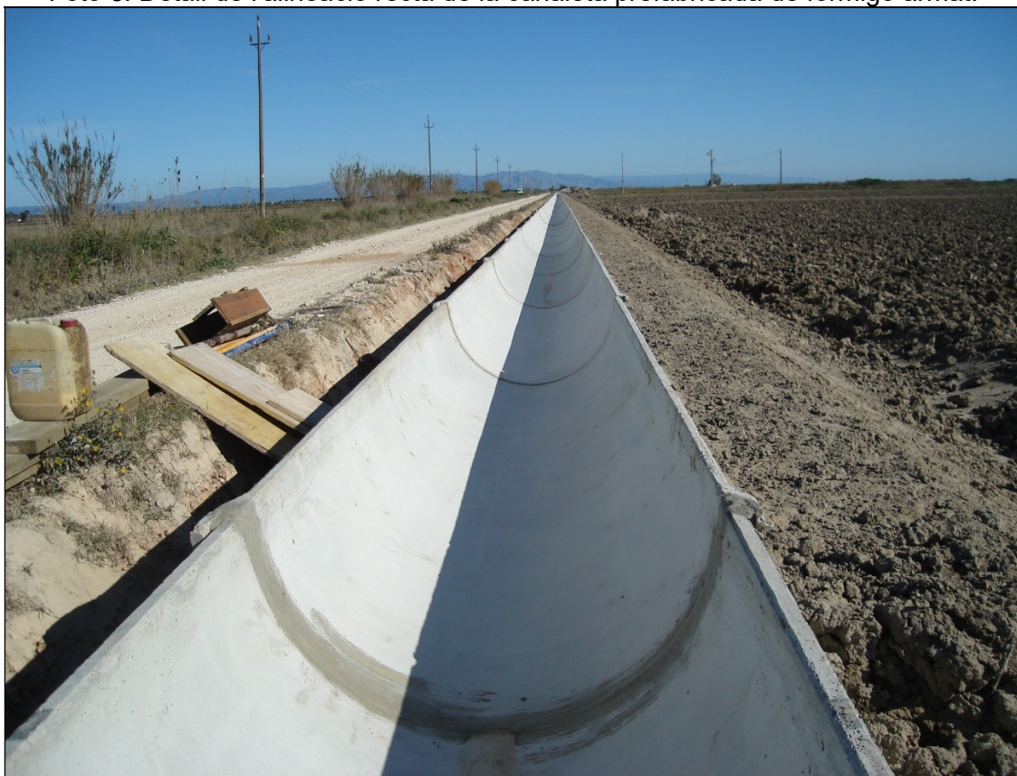
Foto 8: Detall de l'alineació recta de la canaleta prefabricada de formigó armat.
