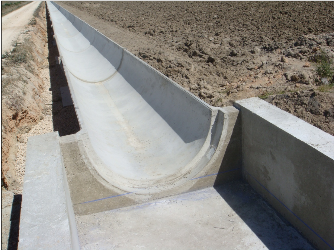
Foto 10: Detall de rampa per a ànecs i d'altres aus anàtids.
