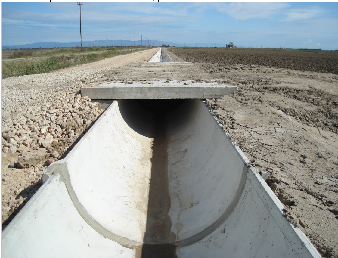
Foto 12: Detall del recolzament d'una canaleta de secció parabòlica en una sabata.
