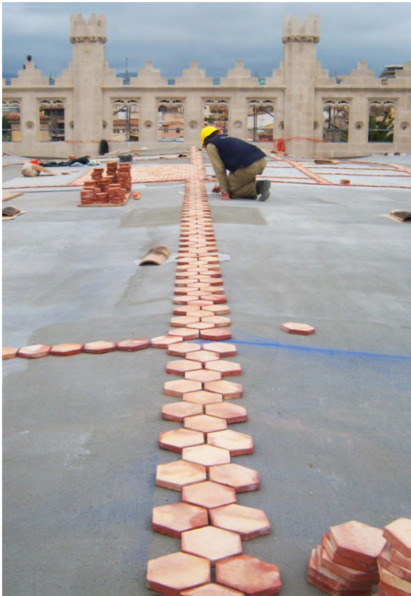
Revestiment amb peces de fang hexagonal fixades amb adhesiu cimentós d' elevades prestacions Keraflex Maxi S1
