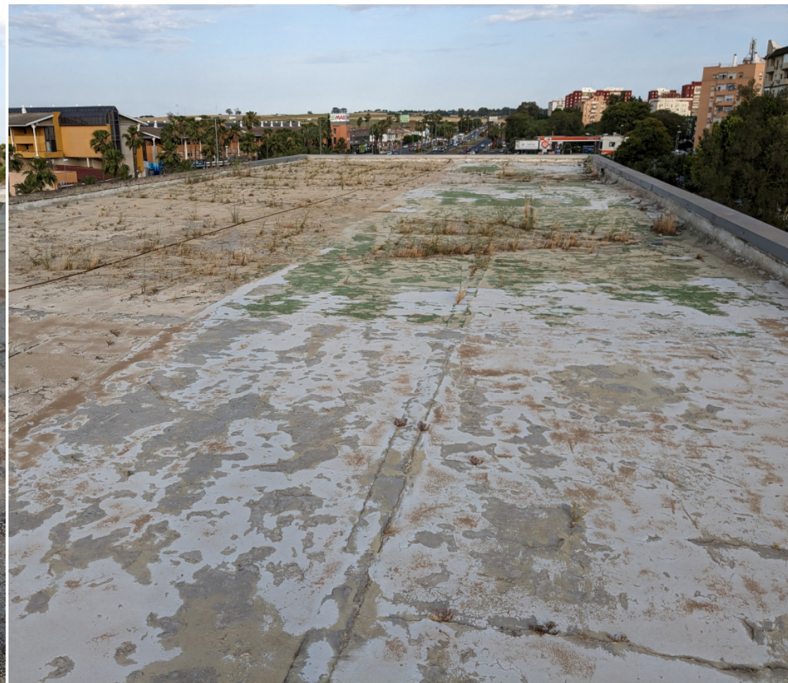
Coberta impermeabilitzada amb tela asfàltica
