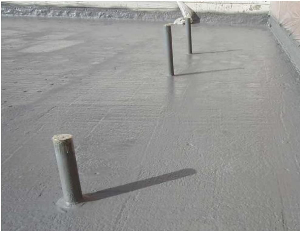
Punts singulars: Elements passants, canaletes, bunera, etc.
