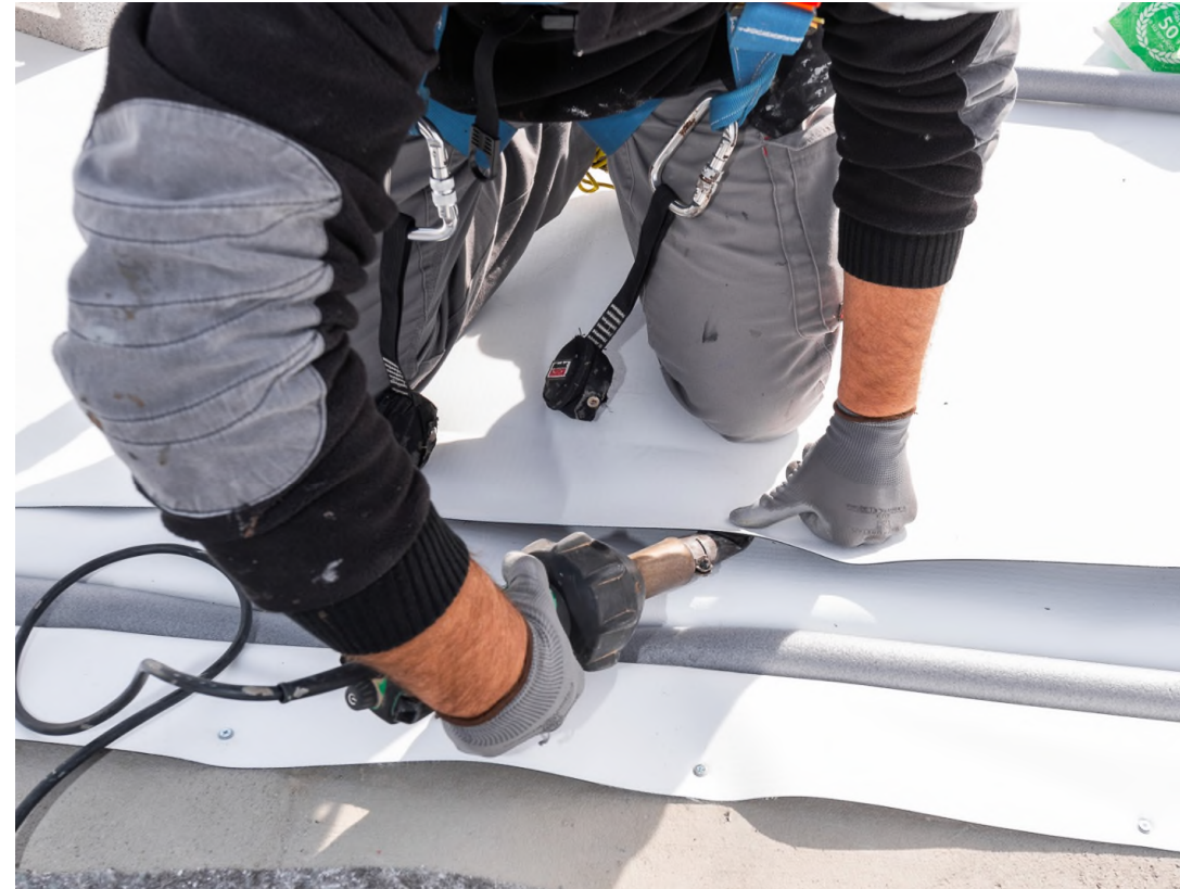
Termosoldat de la làmina a la zona de solapament
