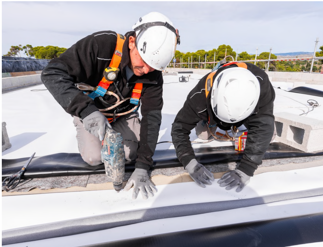
Fixació mecànica amb cargol autotaladrant
