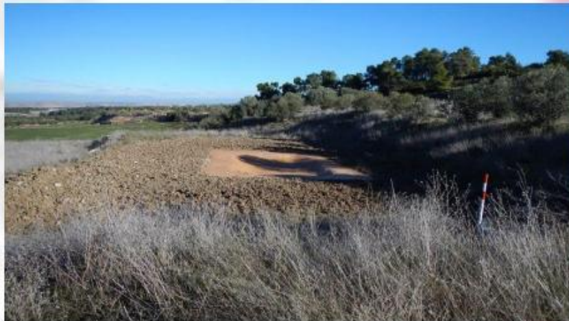
Basses d'amfibis en construcció
