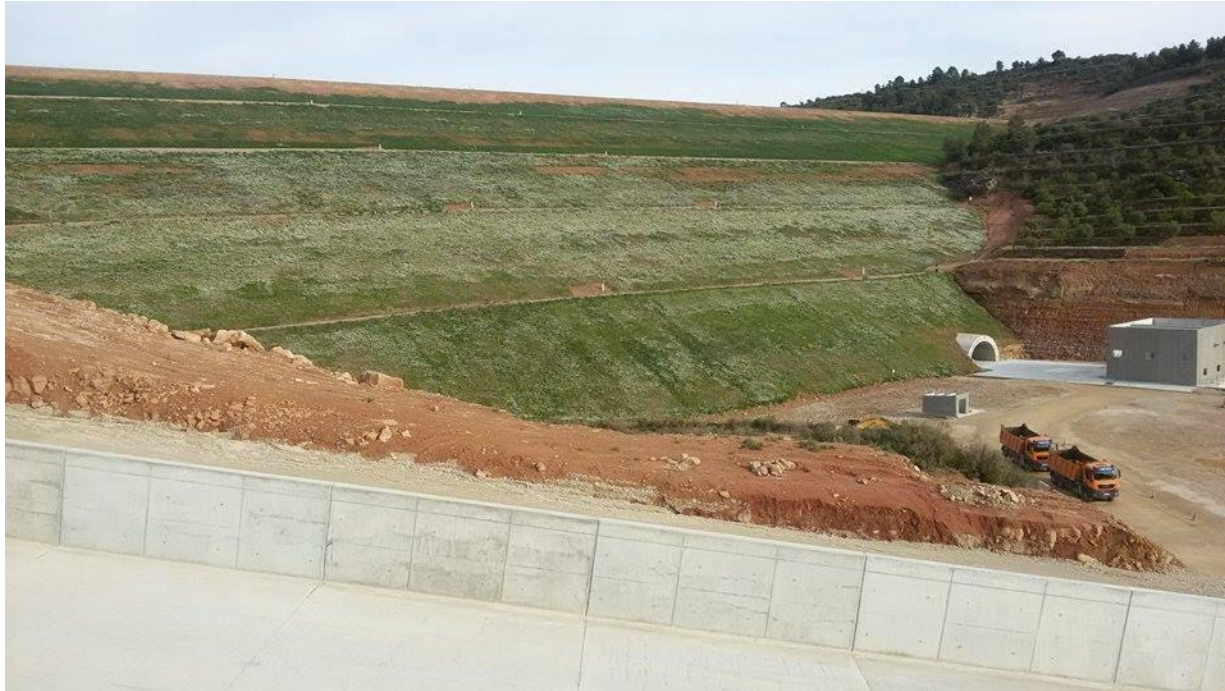
Embassament Albagés (80 hm 3 , obra finalitzada 2017)
