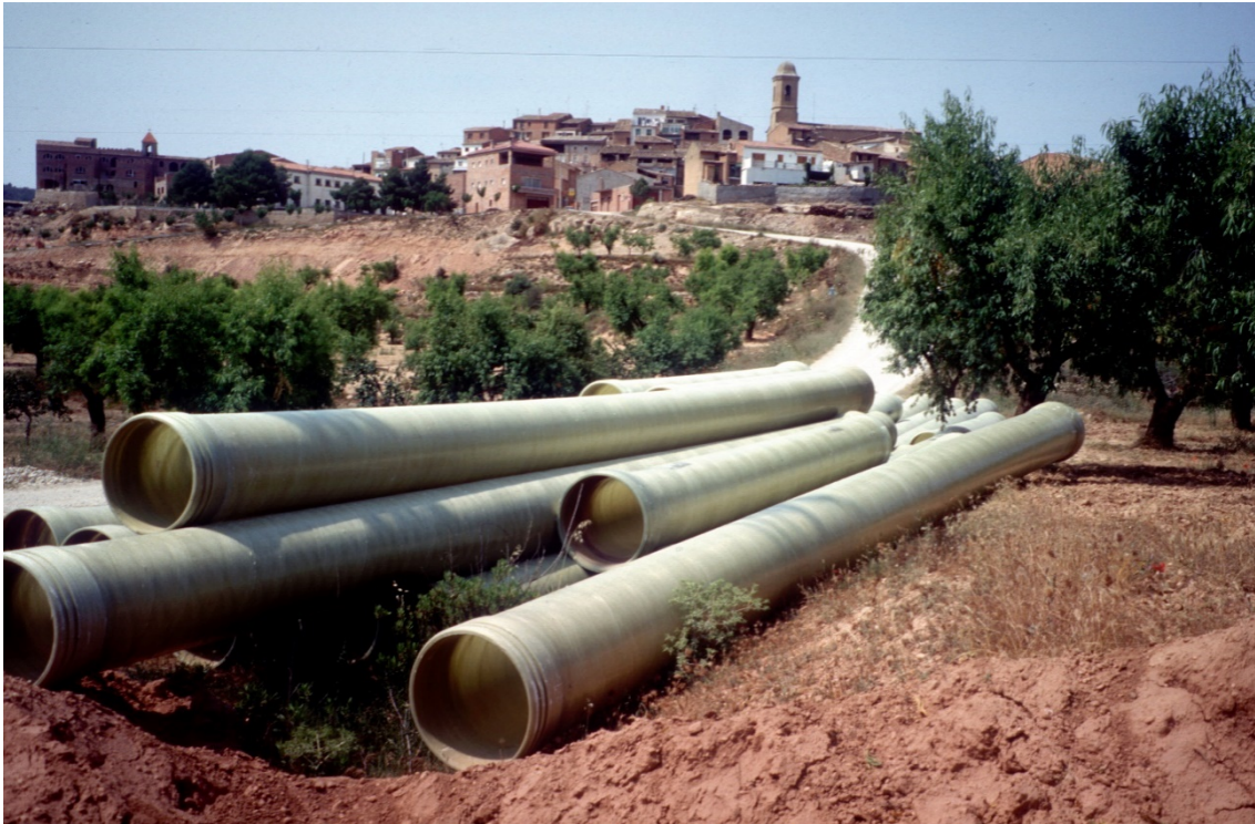
Figura 32. Any 1990. Construcció de la xarxa principal del sistema Garrigues Sud a Bovera (Garrigues).
