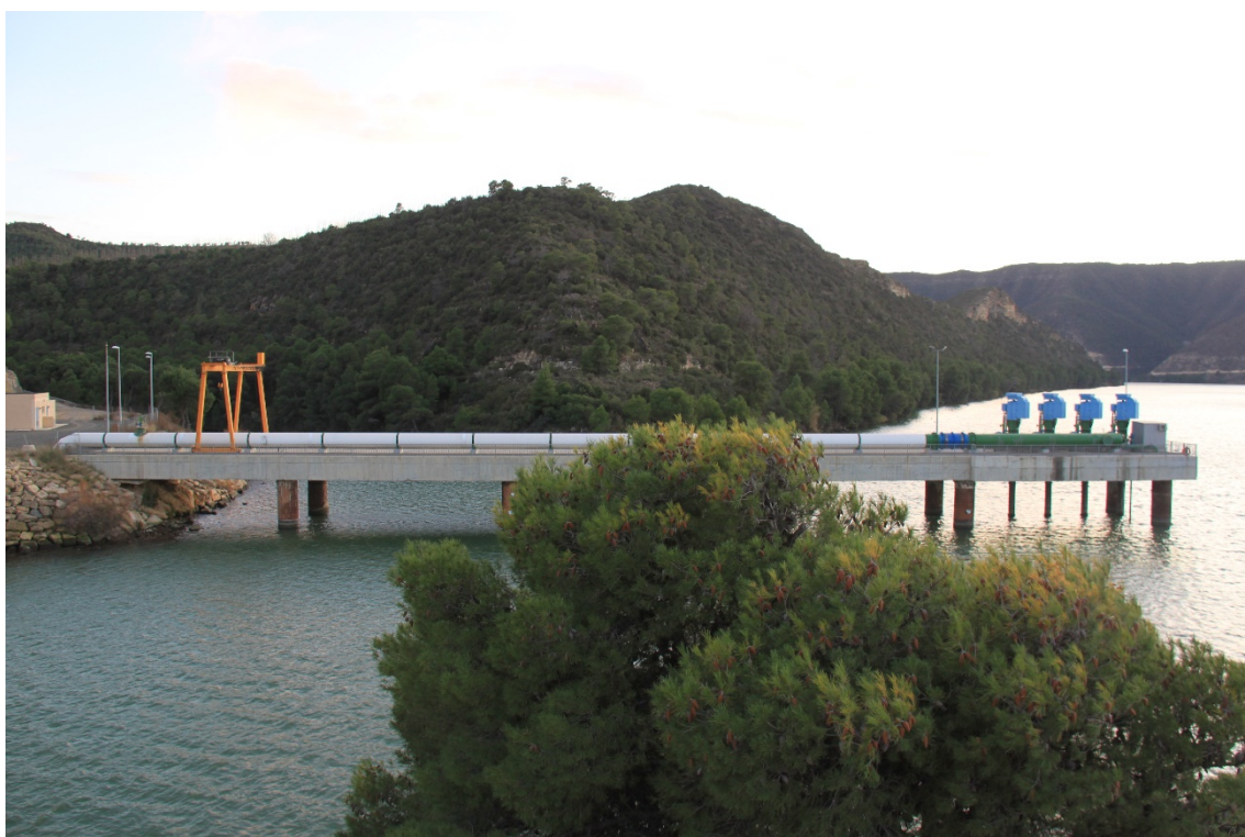
Figura 31. Captació del sistema Segrià Sud al marge esquerra del riu Ebre, Embassament de Riba-roja (Almatret, Segrià).
