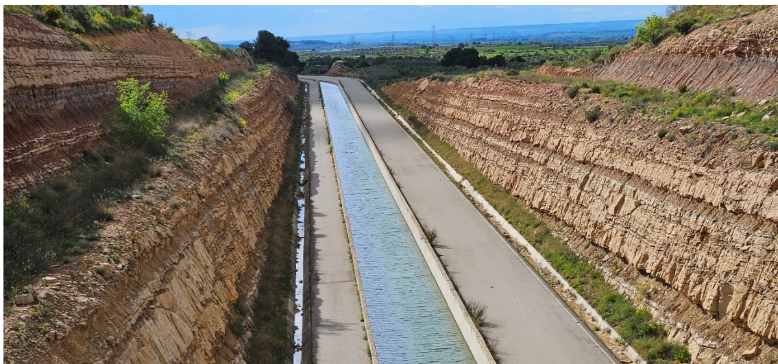
Figura 24. Tram del Canal Segarra-Garrigues en trinxera al seu pas pel terme de la Floresta (Garrigues)
