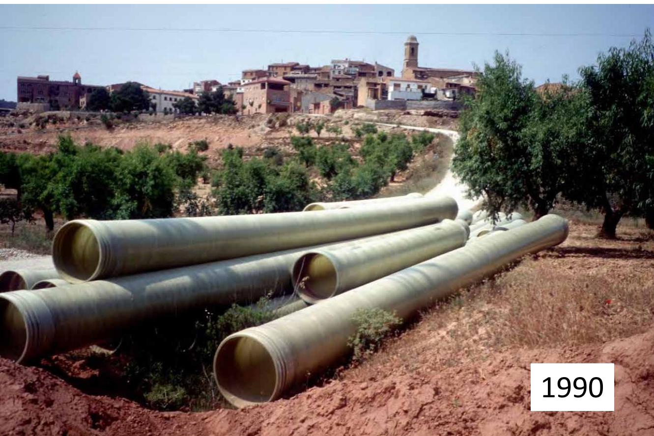
Figura 31. Any 1990. Construcció de la xarxa principal del sistema Garrigues Sud a Bovera (Garrigues).
