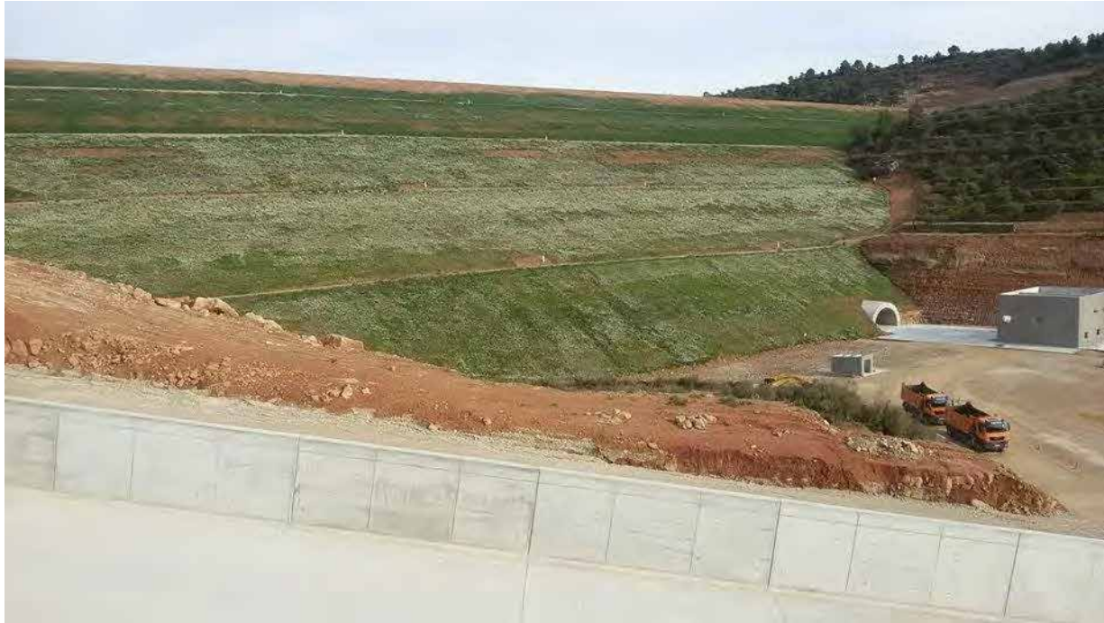
Embassament Albagés (80 hm 3 , obra finalitzada 2017)
