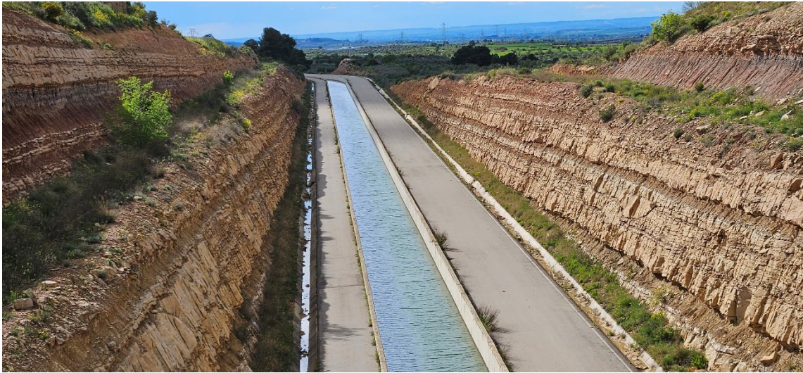
Figura 25. Tram del Canal Segarra-Garrigues en trinxera al seu pas pel terme de la Floresta (Garrigues)
