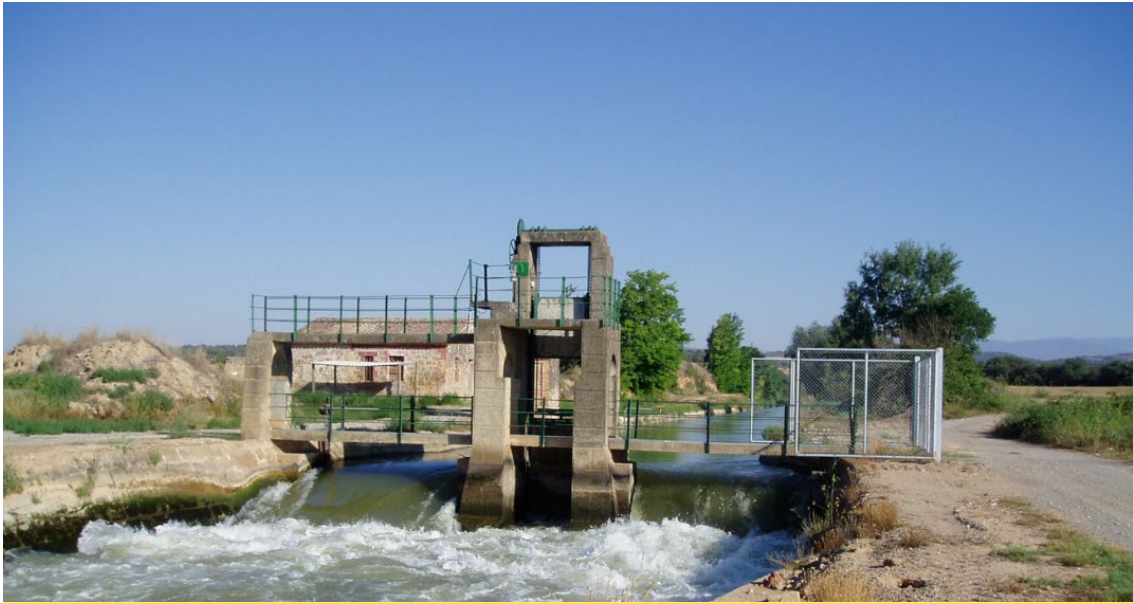
Figura 17. Canal d'Aragó i Catalunya. Control d'alçada de làmina.
