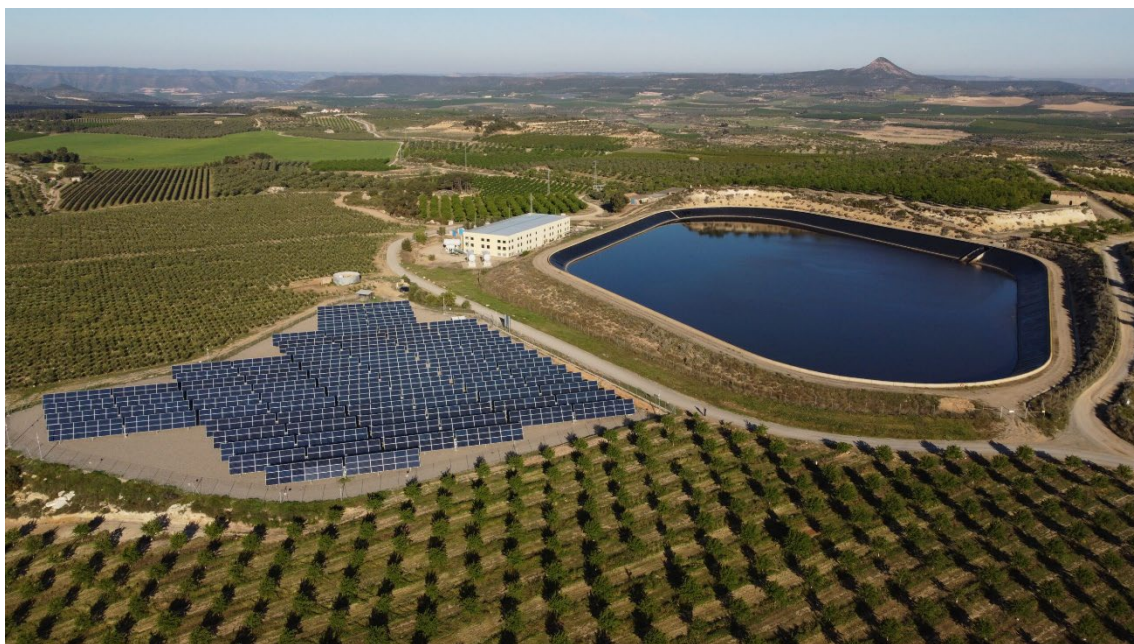
Figura 12. Planta fotovoltaica de subministrant energia a l'estació de bombament de la Comunitat de Regants Segrià Sud a Maials (Segrià) (Font: Gain Agroingenieria).
