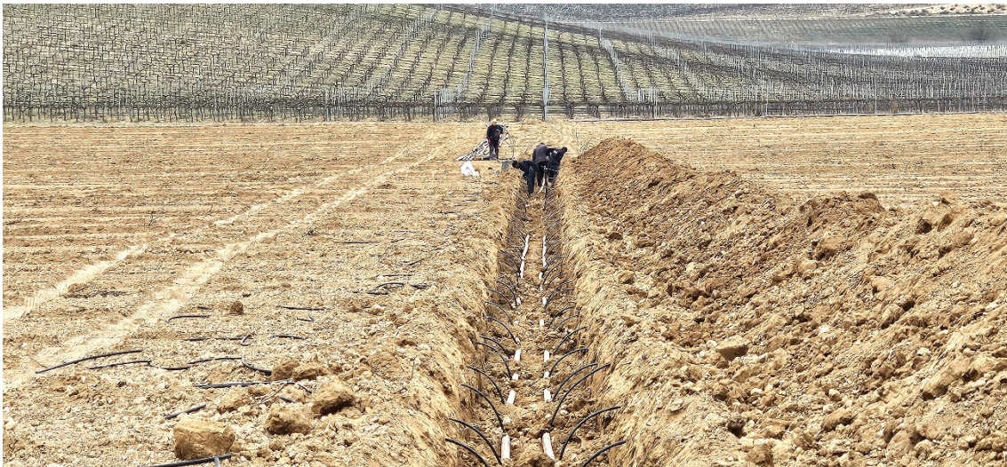
Figura 18. Instal·lació de reg localitzat subsuperficial, prèvia a la plantació de vinya a la zona de Raimat (Segrià).
